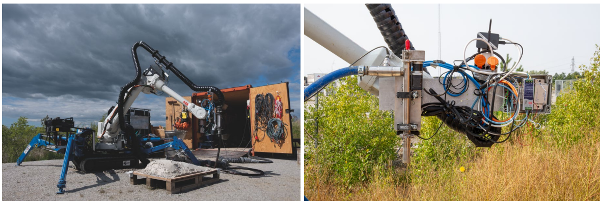
Figur 3. Mobil robotcell på Brunshögstorget i Lund. Figur 4: Extruder monterad på robotarm.
